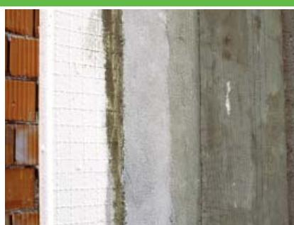
La red en fibra de vidrio **guttarmatex® 160** incorporada como armazón en el mortero del aislamiento térmico exterior con capas permite al sistema una óptima capacidad de resistir a los movimientos de las diferentes capas provocados por los puentes térmicos
