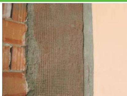
El uso de la red en fibra de vidrio **guttarmatex® 110** para morteros gruesos ya sean interiores o exteriores previene la formación de grietas y fisuras causadas por el asentamiento de materiales diferentes (ladrillos, blo-
